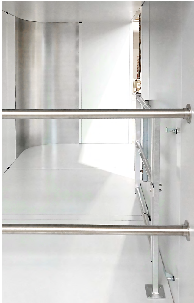
Absturzsicherung sowie Luftleitblech zur Strömungsführung.
