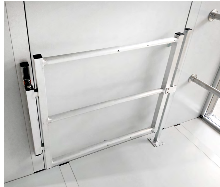
Sicherung der Zugangstüre.
