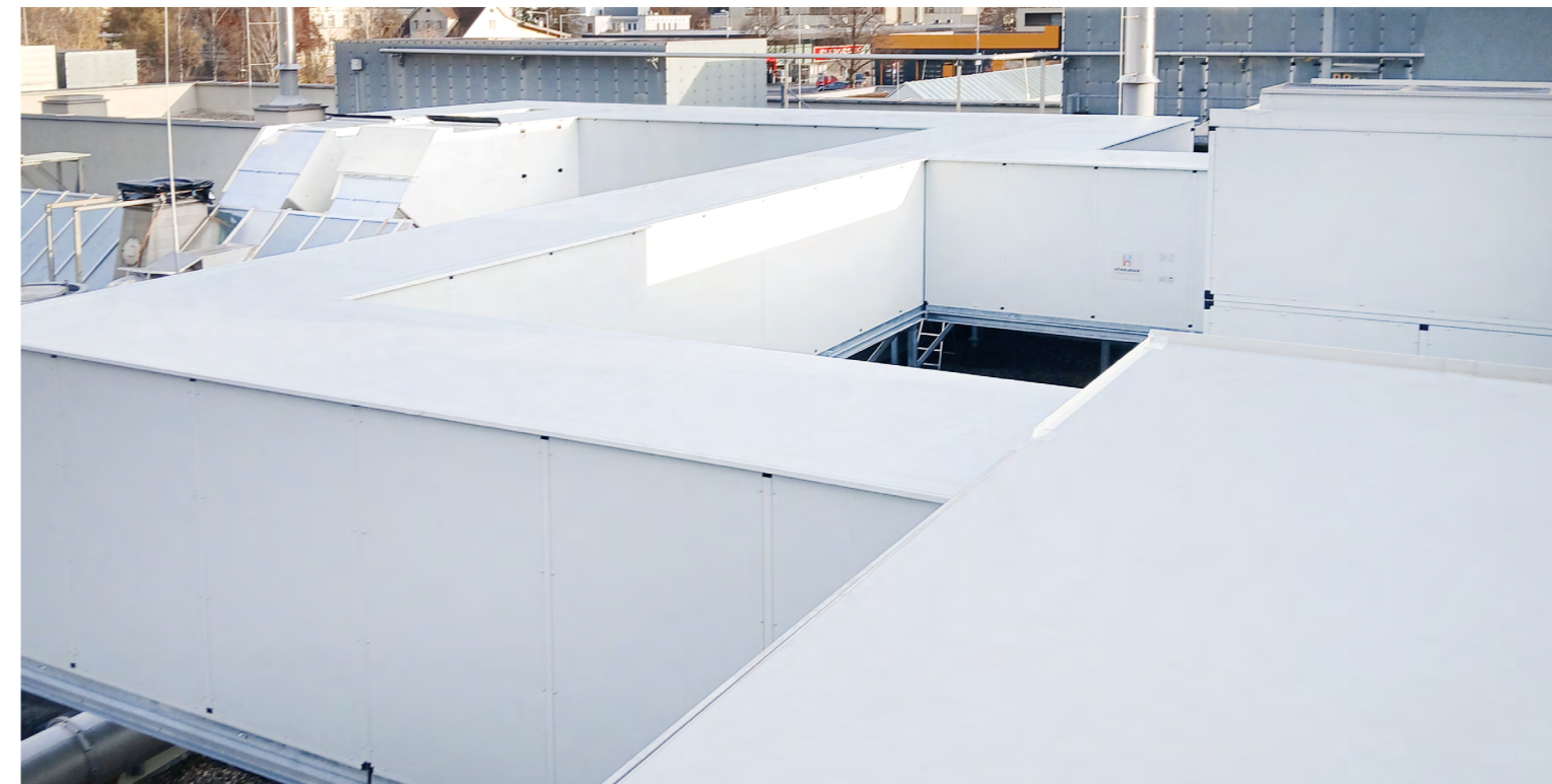
Zu- und Abluftkanalsystem einer Industrielüftungsanlage.
