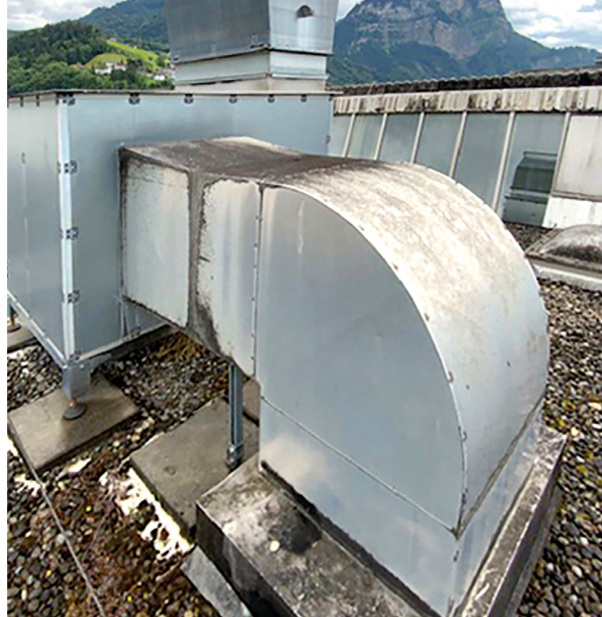
Anschluss an Gerätepaneel sowie Dacheinfassung mit Dichtstoff (ohne mechanische Regendichtheit).
