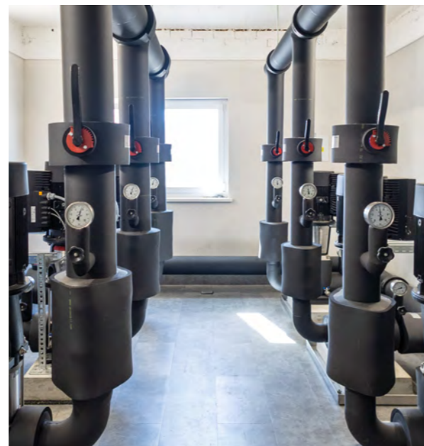
Pumpenzentrale Medienversorgung.
