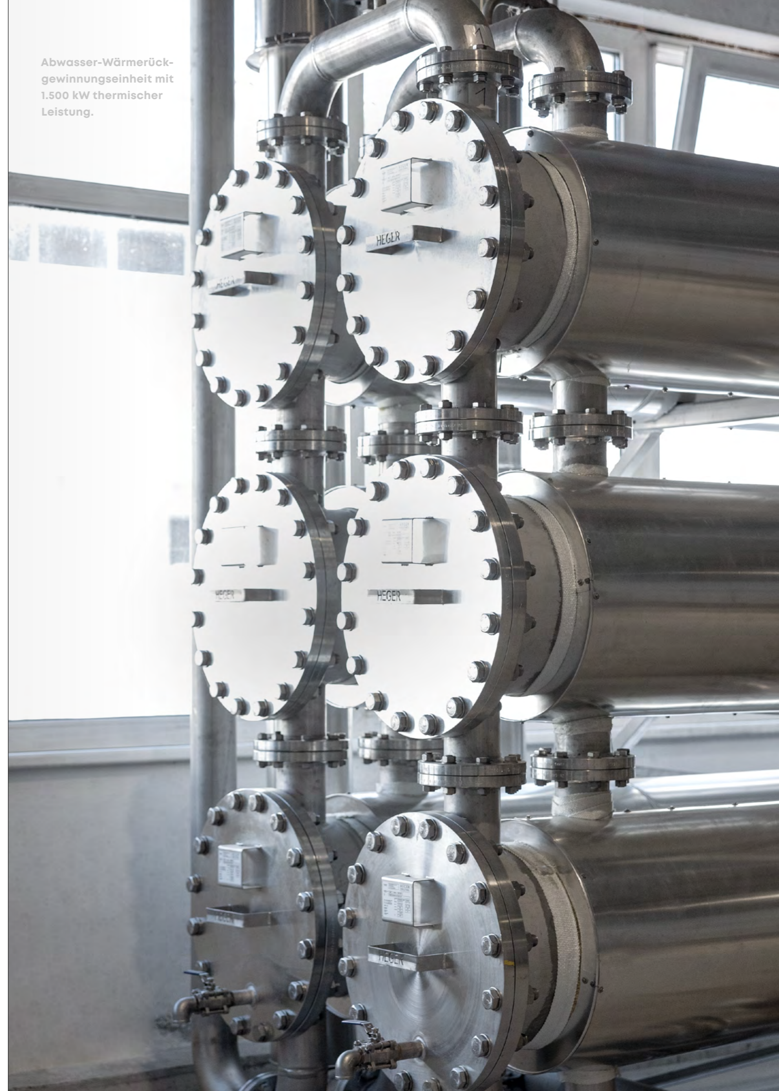
Abwassermanagement für die Wärmerückgewinnung und Neutralisation.
