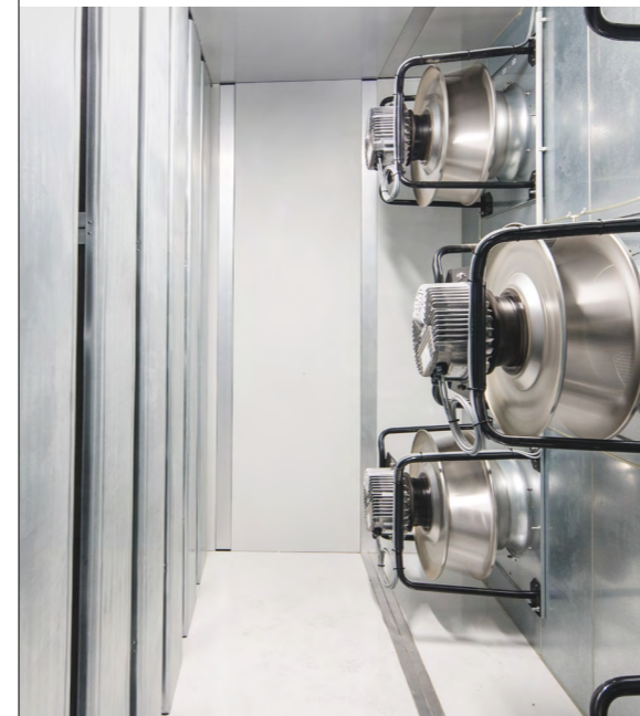
Fanwall für einen energieeffizienten und ausfallsicheren Betrieb.
