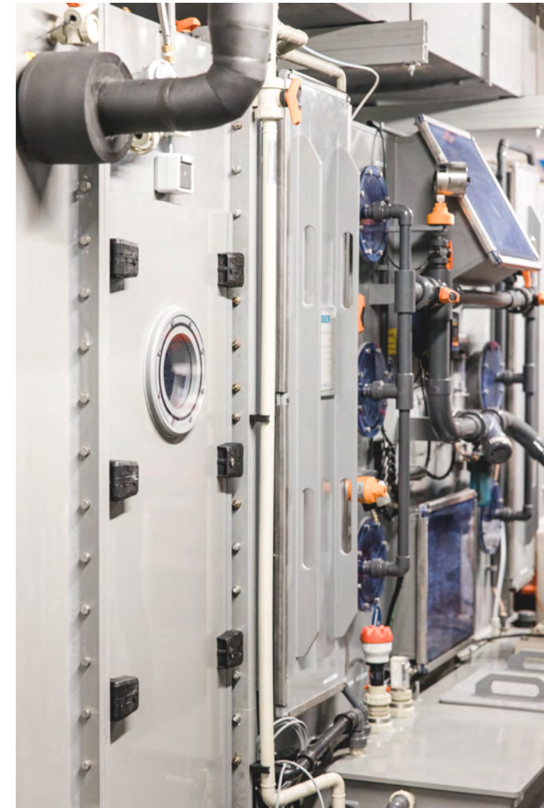
Luftwäscher zur Abluftreinigung.
