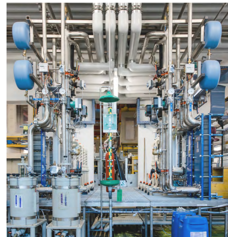
Vorgefertigtes Heiz-, Kühl- und Wärmerückgewinnungsmodul in Edelstahlausführung für höchste Korrosionsbeständigkeit.
