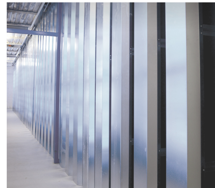
Schalldämpfereinheit zur Ableitung des Kühlluftvolumenstromes von Kompressoren ins Freie. Titelfoto: saumhuhn / stock.adobe.com
