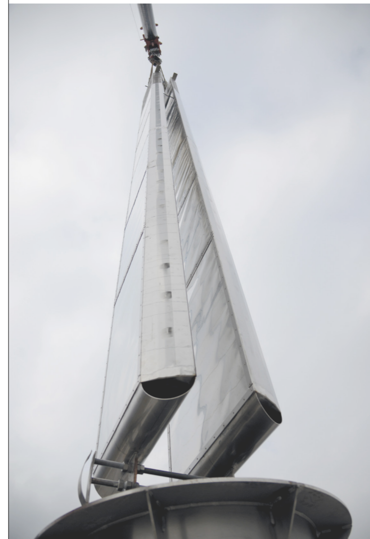
Spezierschalldämpfer für ein Prozessabluftkamin.
