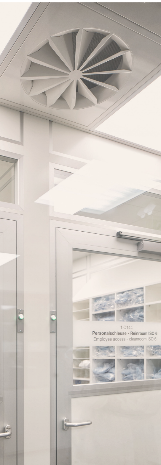
Die Herausforderung: In einen bereits bestehenden Reinraum der ISO-Klasse 8 musste ein neuer Reinraum der ISO-Klasse 6 integriert werden.
