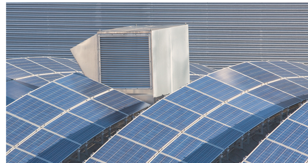
Das spezielle Bogendach der Produktionshalle machte eine einzigartige Konstruktion für die Anbringung der PV-Module erforderlich.
