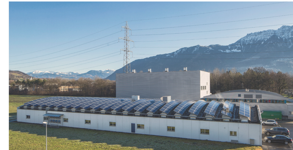
Die Photovoltaik-Anlage auf der VAT-Produktionshalle in Haag erstreckt sich über eine Fläche von rund 860 m 2 .
