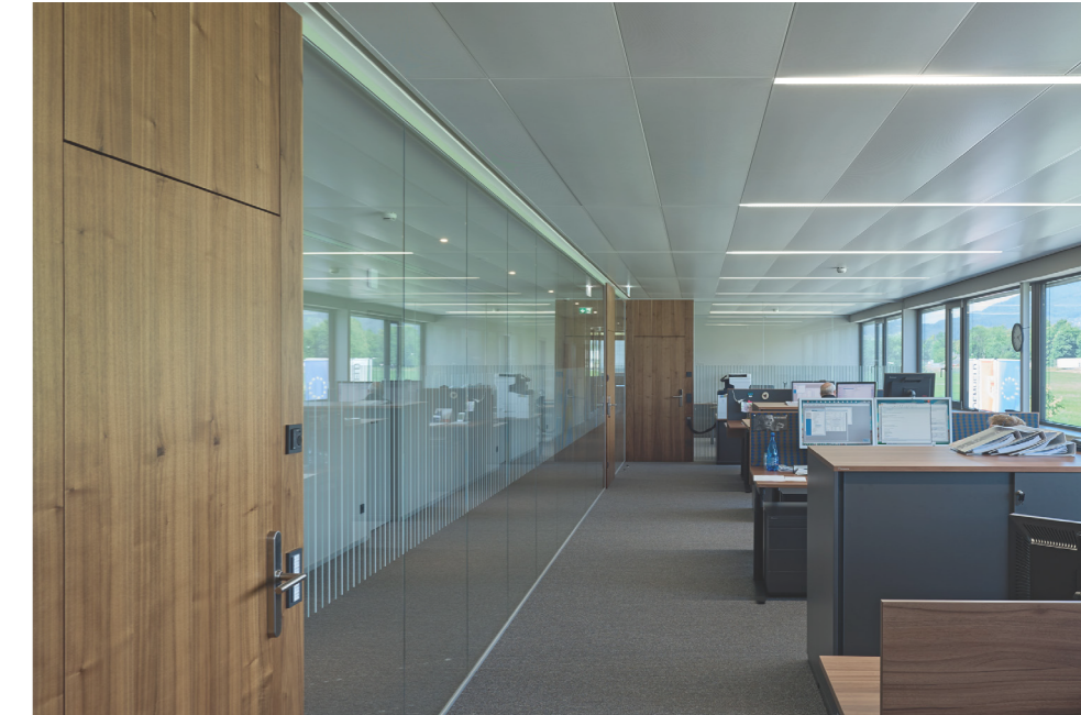
Ein Belüftungssystem mit Wärmerückgewinnung in Kombination mit thermisch aktiven Metaldecken sorgt für angenehmes Raumklima.
