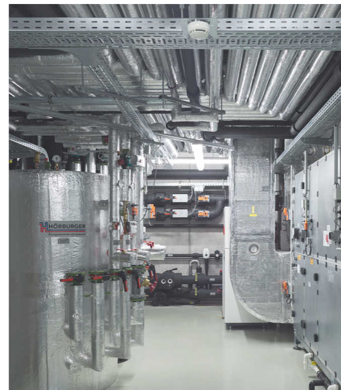
Blick in die Technikzentrale. Die komplette Verrohrung wurde vorab in 3D geplant und bei Hörburger vorgefertigt. So konnten die Montagezeiten auf der Baustelle sehr kurz gehalten werden.
