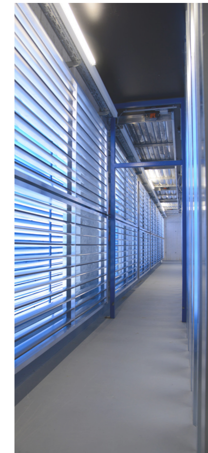
Luftmischkammer mit Wartungsgang.
