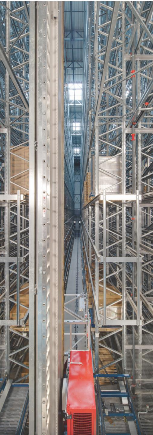
Das neue Lager besteht mit einer Höhe von 27 Metern und 6.500 Paletten-Stellplätzen. Hörburger entwickelte ein spezielles Lüftungssystem zur Beheizung und Konditionierung.
