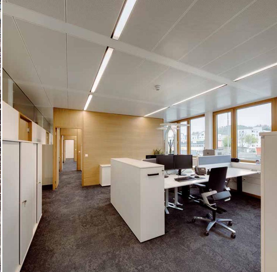
Optimale Arbeitsbedingungen: Ein Belüftungssystem mit Wärmerückgewinnung in Kombination mit thermisch aktiven Metalldecken sorgt für Frischluftzufuhr.
