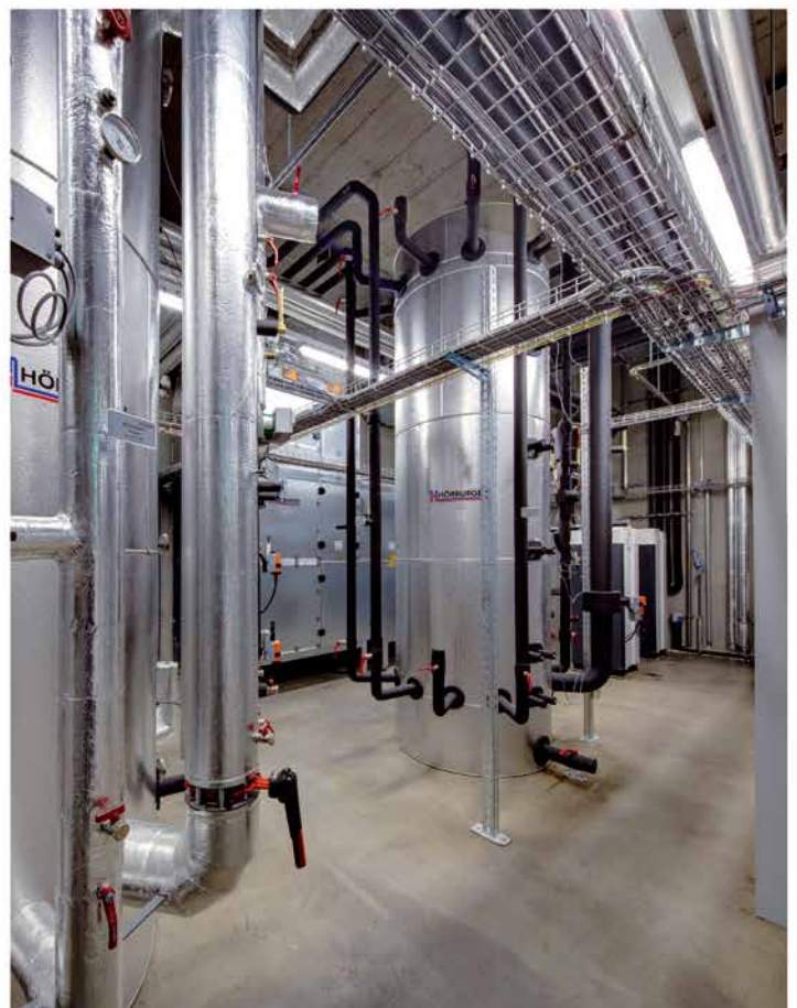
Die komplette Verrohrung wurde vorab in 3D geplant und bei Hörburger vorgefertigt. So konnten die Montagezeiten auf der Baustelle sehr kurz gehalten werden.
